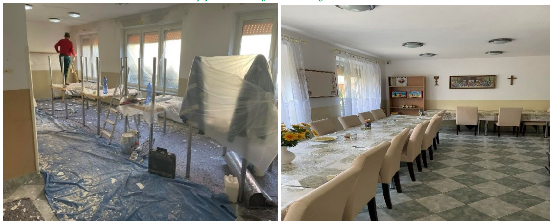
Maľovanie a obnova stravovacej prevádzky a chodby
