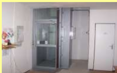
Dodávka a montáž osobného výtahu DD Ležárovce
